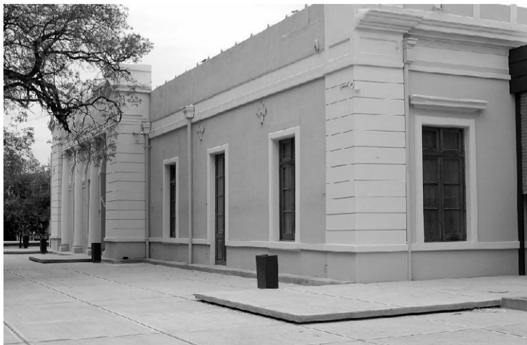
La sede del Archivo, en Belgrano Oeste y Cabral (Ciudad), fue el edificio de la estación del Ferrocarril Trasandino.
